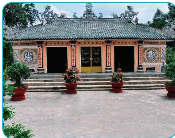
Hình 6.3. Chùa Bửu Hưng (xã Long Thắng, huyện Lai Vung)
